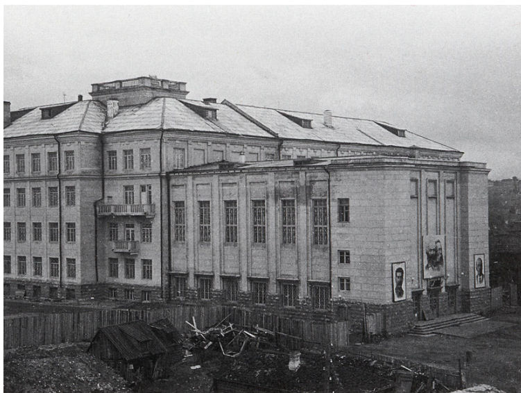
Рис. 4. Здание КФГУ. 1941 г.
